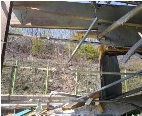
반응기, AN-Filter 설치 위치
